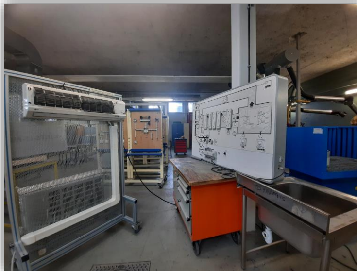
Installations thermiques ET sanitaires
